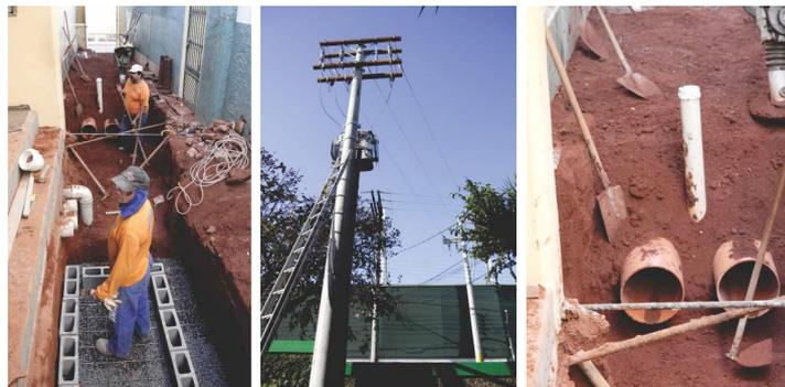
No prédio da Av. 16, foi executada uma obra para a instalação de um novo transformador trifásico, que comporta uma carga de energia três vezes superior à atual. A fachada do prédio ganhou um novo poste, que abriga o transformador ligado à rede da concessionária Elektro. A parte elétrica foi refeita, com a instalação de uma nova caixa de distribuição.
